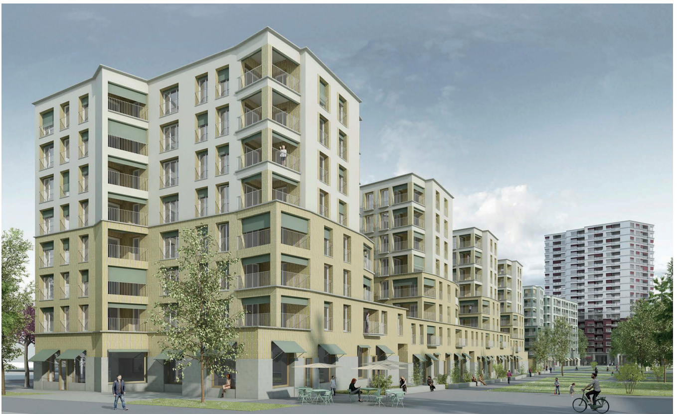
Ansicht Südfassade, Blick Richtung Grünzug Dreispitz
