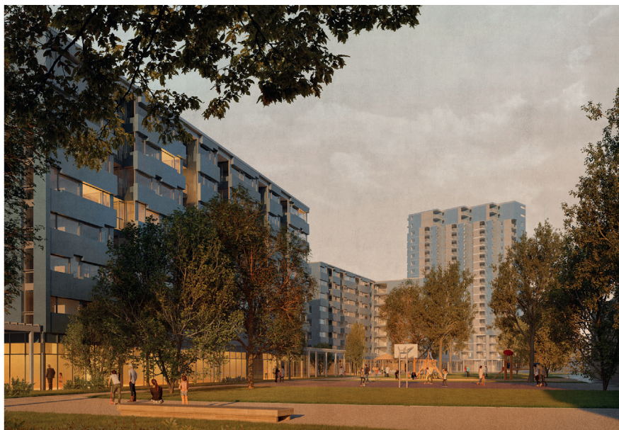
Ansicht Südfassade, Blick Richtung Grünzug Dreispitz
