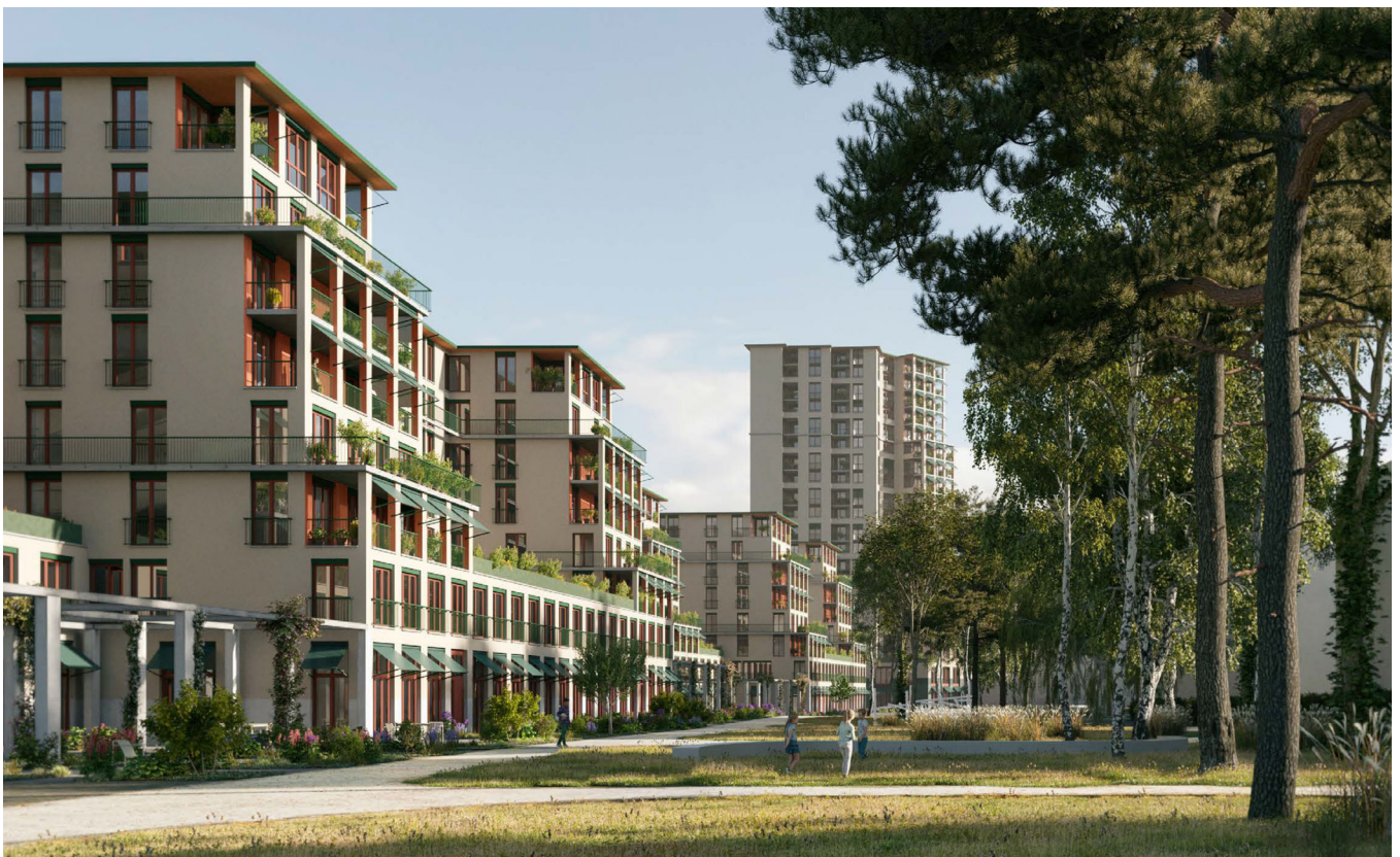
Ansicht Südfassade, Blick Richtung Grünzug Dreispitz
