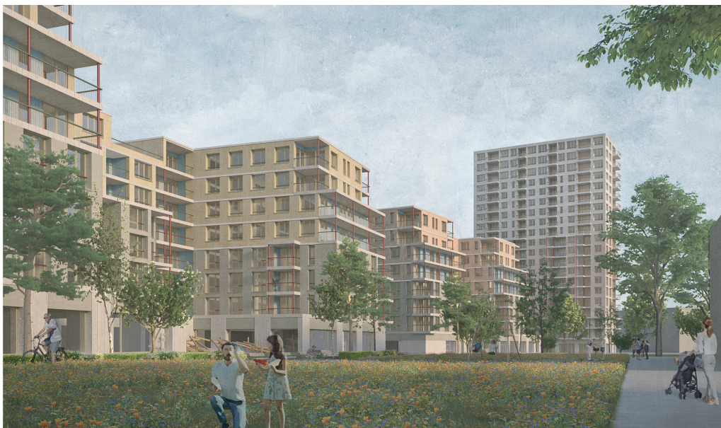
Ansicht Südfassade, Blick Richtung Grünzug Dreispitz
